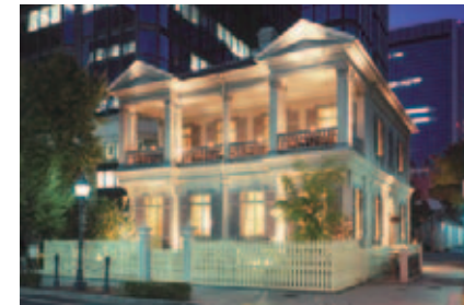
阪神・淡路大震災により崩壊し、その後復元された 「旧居留地十五番館」
