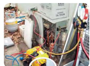
フロン回収装置での回収作業
